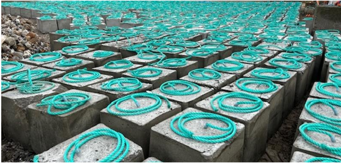
Figure 4: På hver enhed monteres ca. 55 betonklodser med en vægt på 250 kg.
